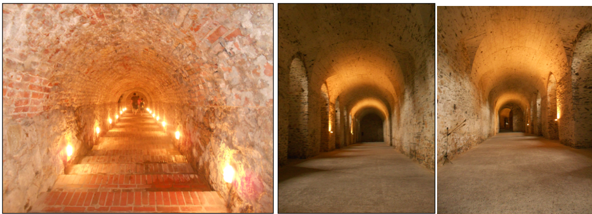
Fig. 9 Cellars of the castle Červený Kameň (photo P. Hronček)
